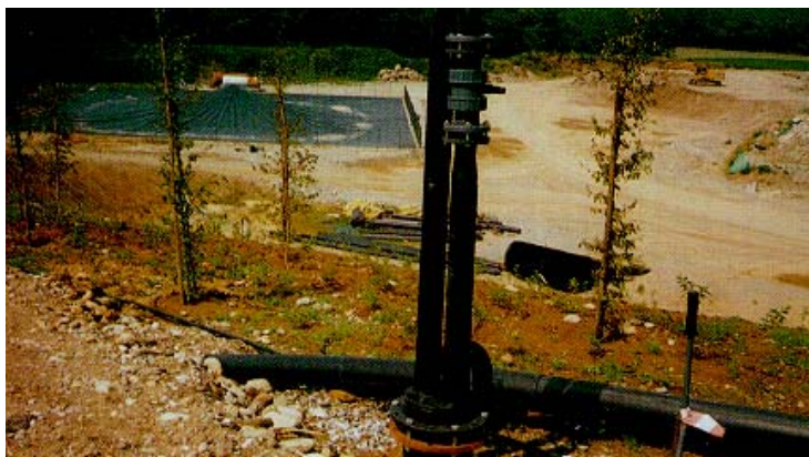
Figura 7.9 - Pormenor da cabeça de um poço de biogás
