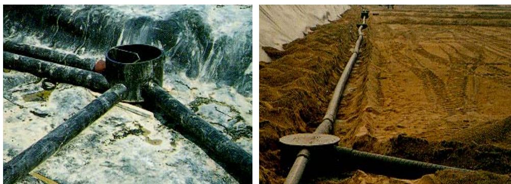
Figura 7.4 - Vista de caixa de fundo de drenagem de lixiviados
